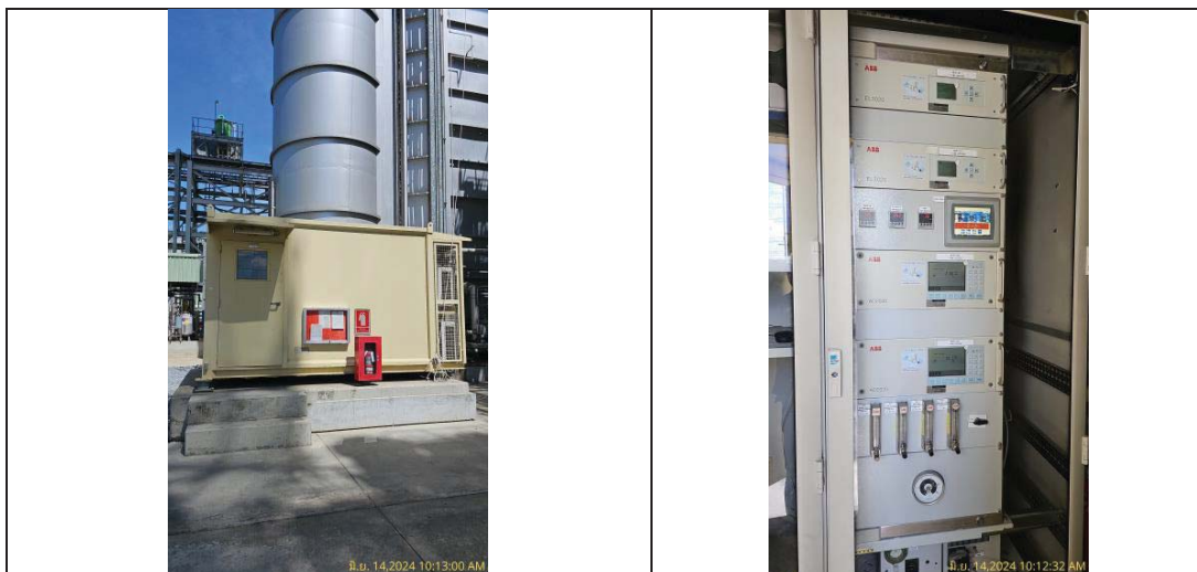
รูปที่ 3.2-1 : ระบบการตรวจวัดคุณภาพอากาศจากปล่องอย่างต่อเนื่อง (CEMS) ของโครงการ
